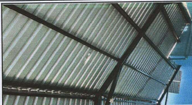
Foto 2: CAMBIO DE LAMINAS EN MAL ESTADO
