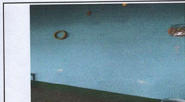
Foto 6: PINTURA EN MUROS INTERIORES E EXTERIORES
