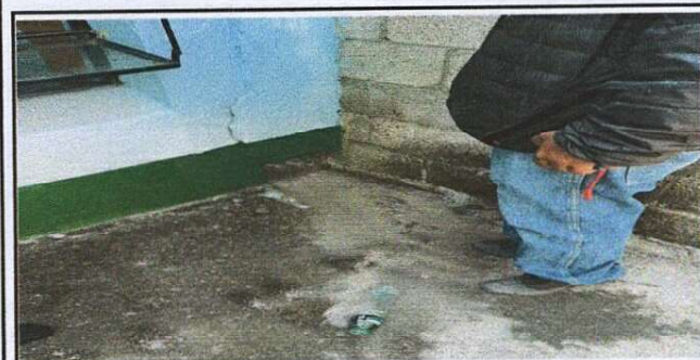
Foto 5: REPARACION LOSA DE PATIO
